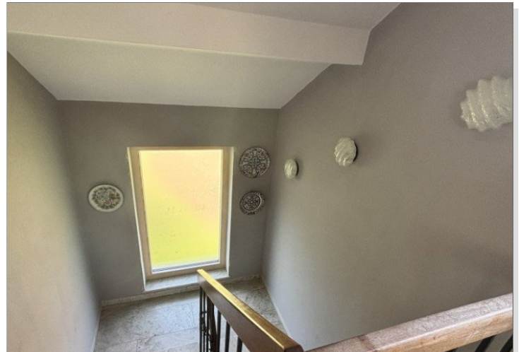
Flur Treppe OG DG
